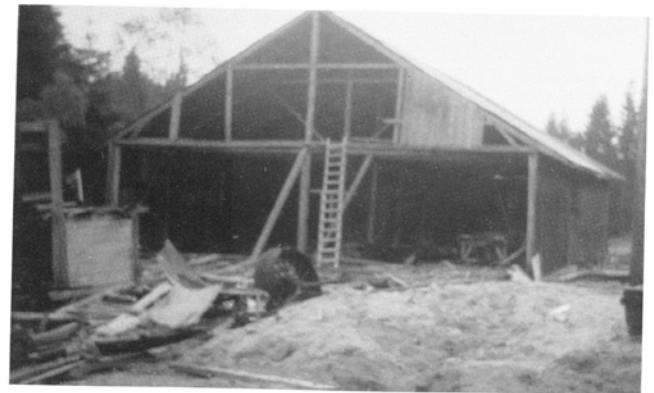
Dette er rester av selve torvstrofabrikken. Fotografiet er tatt rundt 1969. På bildet ses et overføringshjul for reimdriфт brukt i forbindelse med riveren eller pressa. FG og FS: A. N. J.
